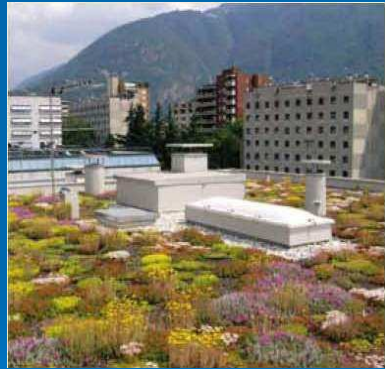
Tetto dell'Istituto per l'edilizia sociale in via Druso a Bolzano
