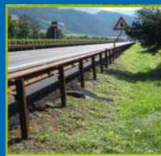
Fosso di infiltrazione lungo l'Autobrennero a Campo di Trens
