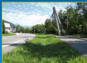
Fosso d'infiltrazione in zona industriale a Bressanone
