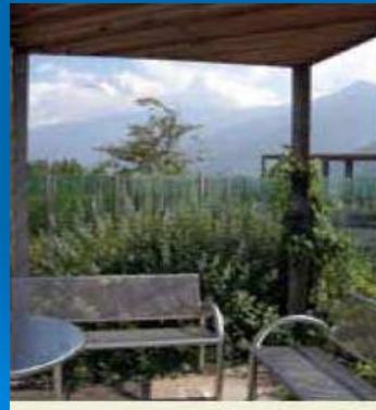
Tetto a verde intensivo dell'Ospedale di Silandro
