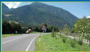
Fosso d'infiltrazione lungo via Brennero a Varna
